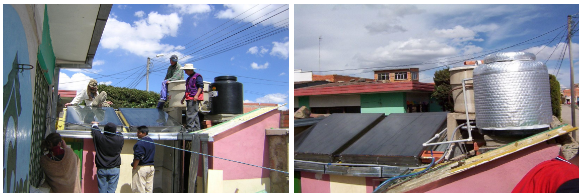
Figure 7: Pose des capteurs sur le toit (gauche). Les connections sont mises en place, et le réservoir d'eau chaude isolé (droite).
