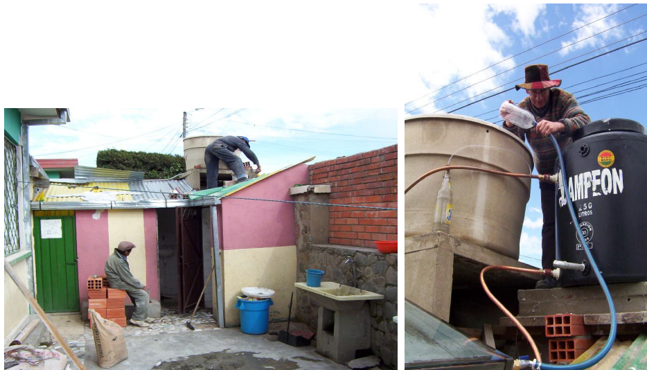
Figure 6: Gauche : le maçon construit le socle soutenant le réservoir d'eau chaude, afin que les réservoirs arrivent à la même hauteur. A droite, les connections entre le capteur et l'échangeur de chaleur sont établies. On distingue le vase d'expansion (bouteille en verre) relié au point haut du circuit. Laurent remplit le circuit de chauffage à l'aide d'un entonnoir relié à l'entrée du capteur qui est munie d'un robinet de vidange.
